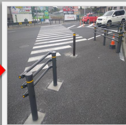
ガードレールを設置し、横断者の安全を図りました。
