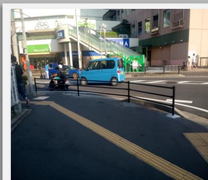
事故防止要望に沿いガードレールを設置
