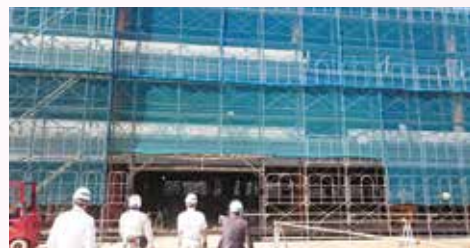
習志野市新庁舎工事の様子
